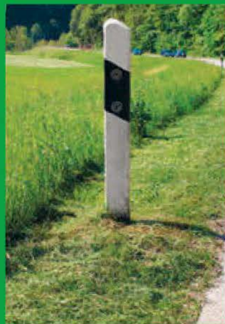
Klipning omkring kantpæle
